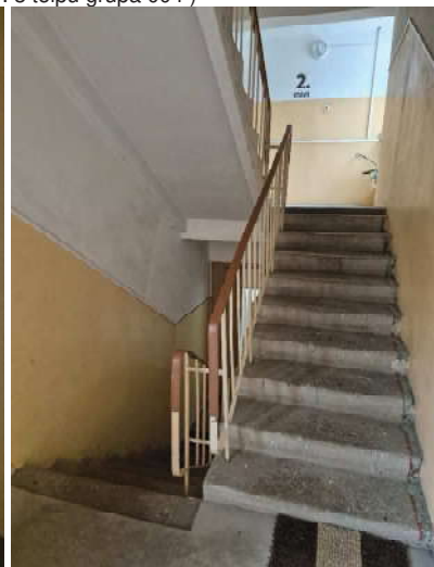
Kāpņu telpa (telpa Nr. 4 telpu grupa 901)
