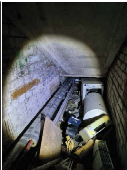
Kāpņu telpa (telpa Nr. 9 telpu grupa 901)
