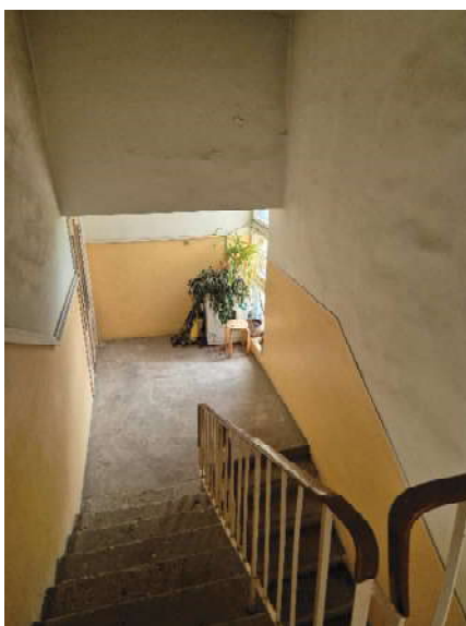
Kāpņu telpa (telpa Nr. 7 telpu grupa 901)
