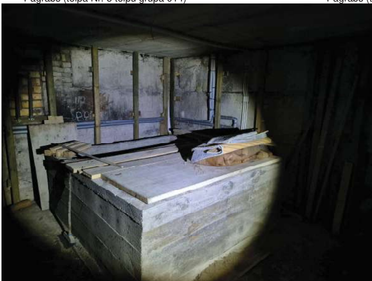
Neizbūvēta telpa (telpa Nr. 2 telpu grupa 014)
